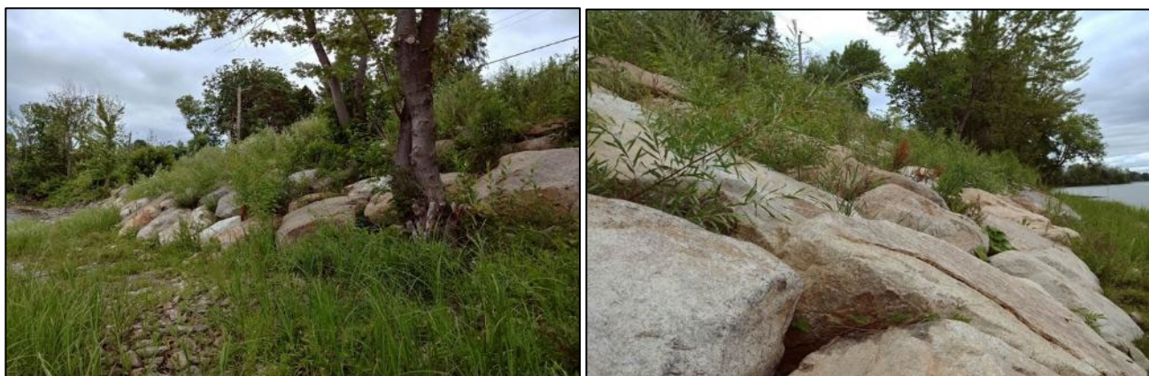
Figure 8. Technique mixte, exemple d'un enrochement végétalisé (tiré de Aubier Environnement, 2022).
