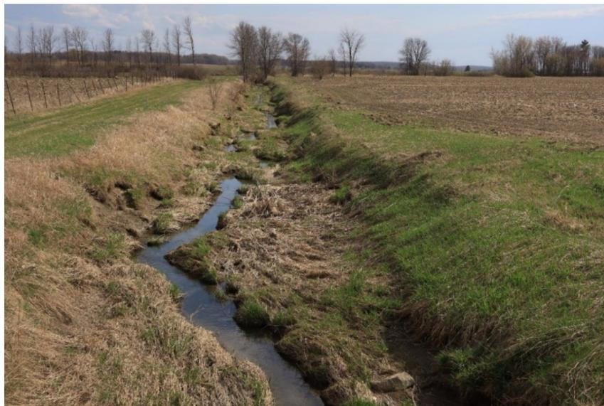
*Figure 4. Cours d’eau situé dans la MRC Brome-Missisquoi aménagé de façon conventionnelle et ayant développé une section d’écoulement à deux niveaux (source : Nicolas Stämpfli).*
