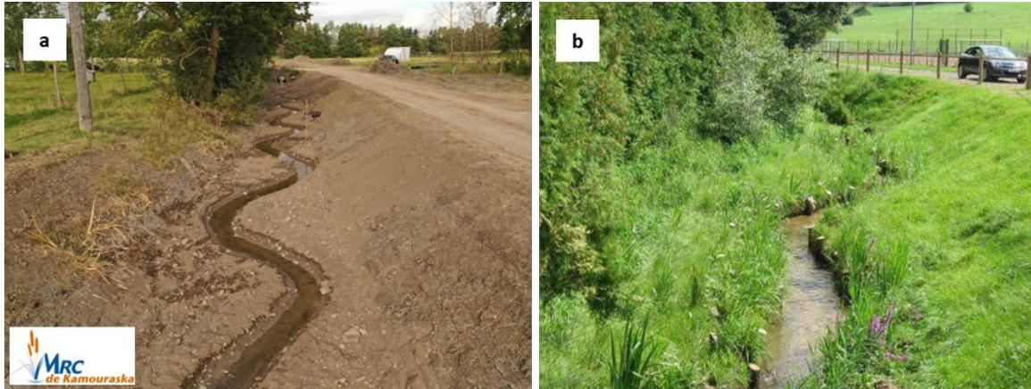
Figure 6. (a) banquettes récemment aménagées avec un mélange granulaire à la Décharge du Collège, La Pocatière (Rivières, OBAKIR, MRC Kamouraska et ITAQ) et (b) banquettes quelques années après l'aménagement en France (SOGREAH, 2010).
