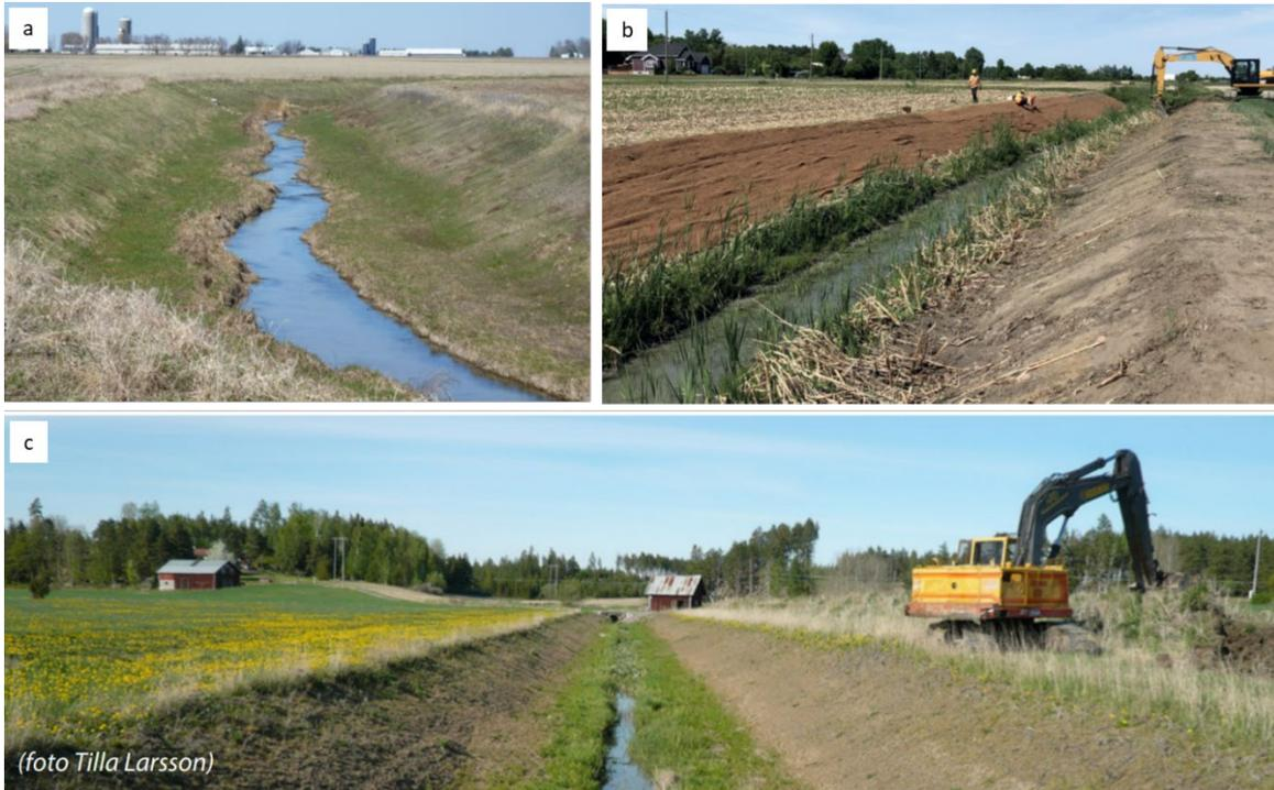
Figure 5. Exemples de cours d'eau à deux niveaux créés par excavation : (a) ruisseau Mullenbach, Minnesota moins de deux ans après l'installation (tiré de Kramer, 2011) ; (b) cours d'eau à deux niveaux en construction à Saint-Jean-Baptiste, Montérégie (source : UPA Montérégie, 2021) et (c) cours d'eau à deux niveaux en Suède.
